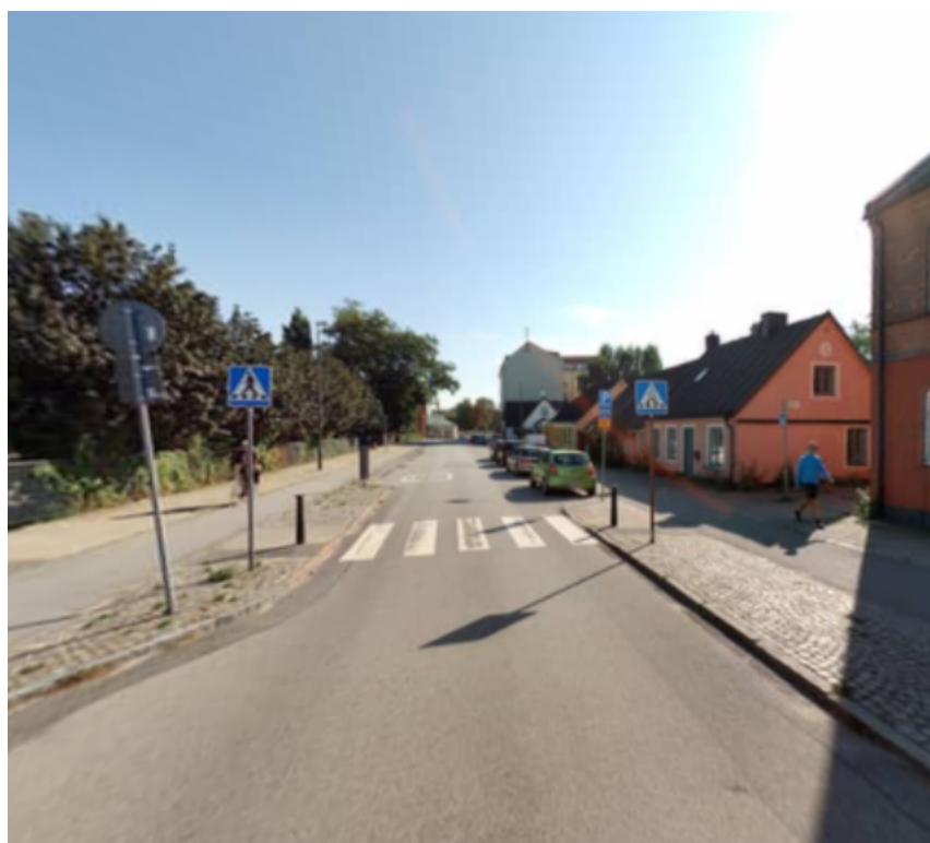
Figur 3. Övergångsställe och avsmalnad körbana vid korsningen Norra Bulltoftavägen-Källargatan.
